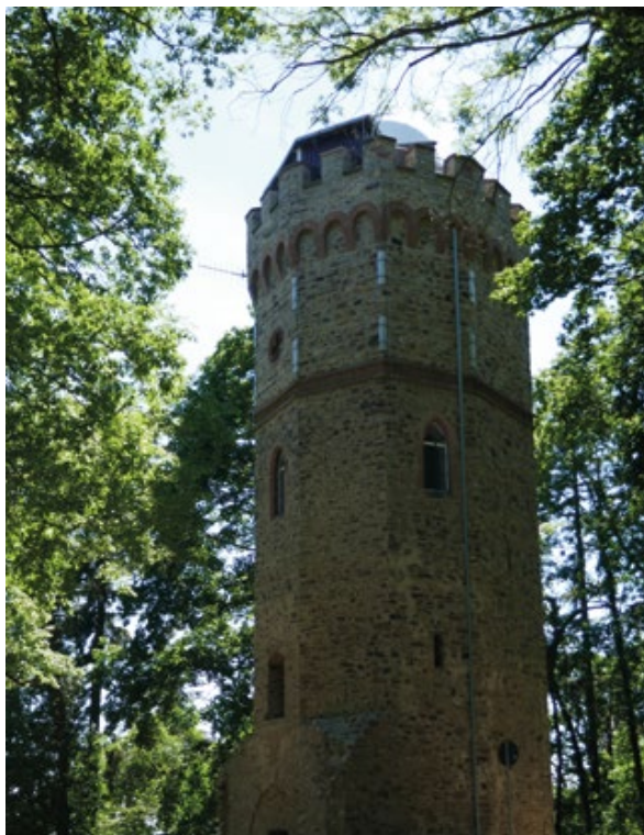
Abb. 5: Ansicht des Johannisturms von Nordost (2020)
