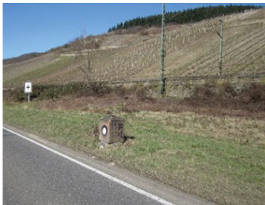
Abb. 22: Myriameterstein steht lose auf dem Sockel (2011).
