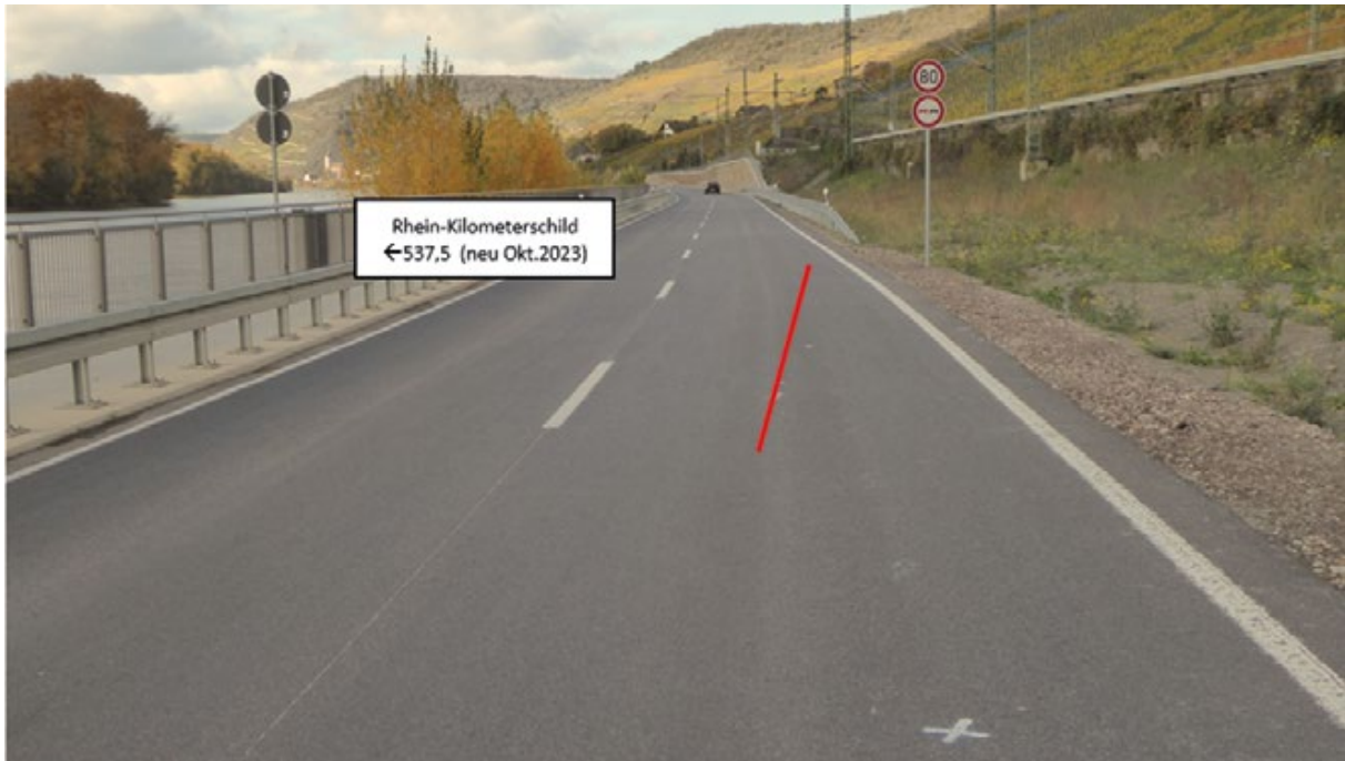
Abb. 26: Position des ehemaligen Myriametersteins 37 in Lorch/Rhein nach Abschluss des Radwegebaus an der B 42. Das Kreuz auf dem Asphalt im Vordergrund kennzeichnet die abgesteckte Position nach Koordinaten. Links am Geländer das neu angebrachte Hektometerzeichen 537,5. Unter Berücksichtigung der in Abb. 25 dargestellten Sichtachse (in Rot) könnte die tatsächliche Position noch mehr zur Straßenmitte hin gelegen haben.
