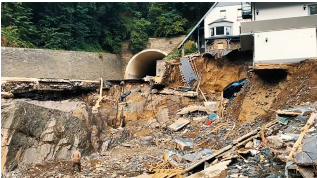
Abbildungen 1 und 2 – Zerstörungen nach der Flutkatastrophe
